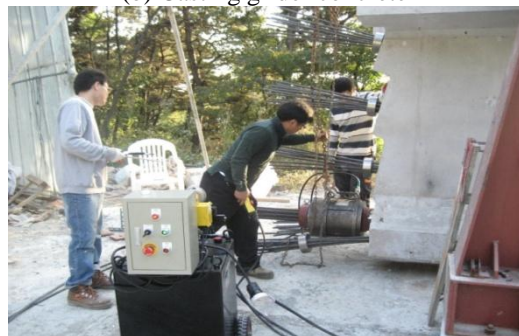
(d) First prestressing and assembly of segments
