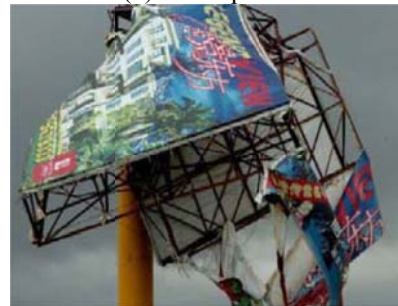
(d) Failure of plate supporting structure
