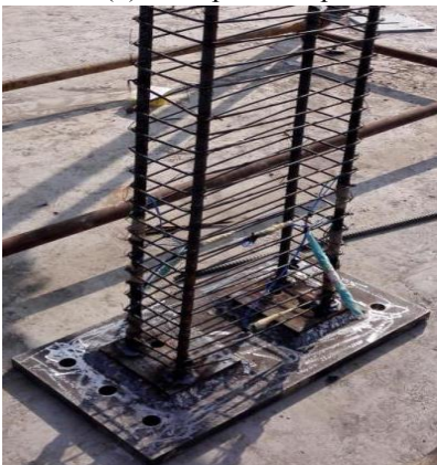
(d) Reinforcement skeleton of precast beam
