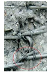
(d) Hoop reinforcement
