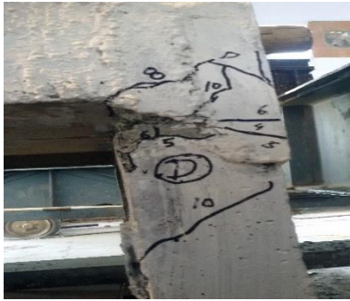
(d) Cracks in Column D
