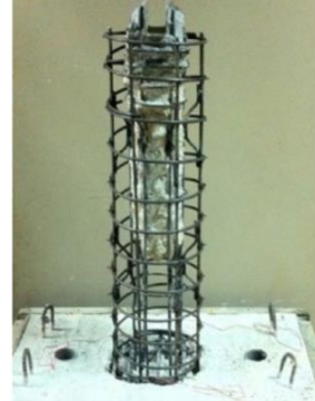
(d) Longitudinal and transverse (spiral) reinforcement of the RC jacket
