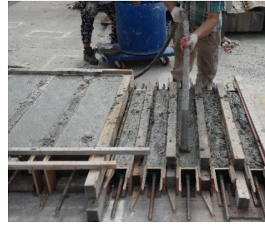
(a) Pouring concrete
